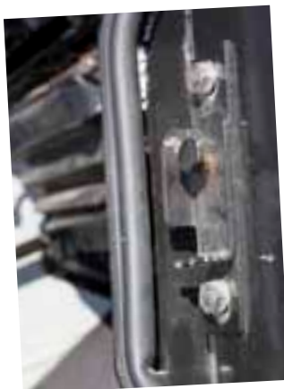
Nye lister ved dørene er også monteret.
